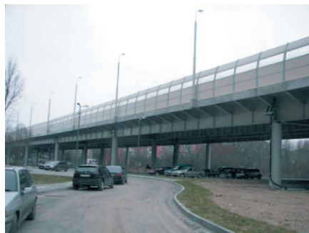
Второй эстакадный мост, г. Калининград
