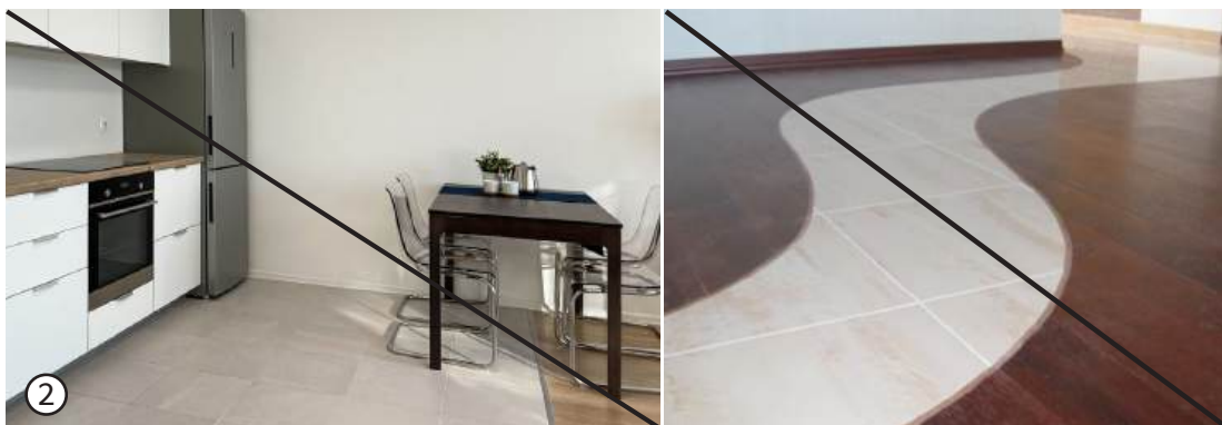
2. Стыки порожками. Чтобы этого избежать, не следует использовать для зонирования разные материалы. Чаще всего так происходит в помещениях, где есть мокрая зона (кабинет СБО, кулинарная студия, мастерская по работе с глиной, лаборатории). Современные бесшовные материалы для общественных зданий обладают всеми характеристиками износостойкости и не требуют выделения мокрых зон керамогранитной плиткой
