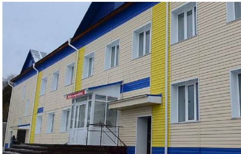
Школа № 93, с. Лебяжье, Алтайский край
