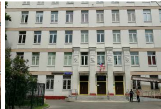
Коррекционная школа № 825, г. Москва
