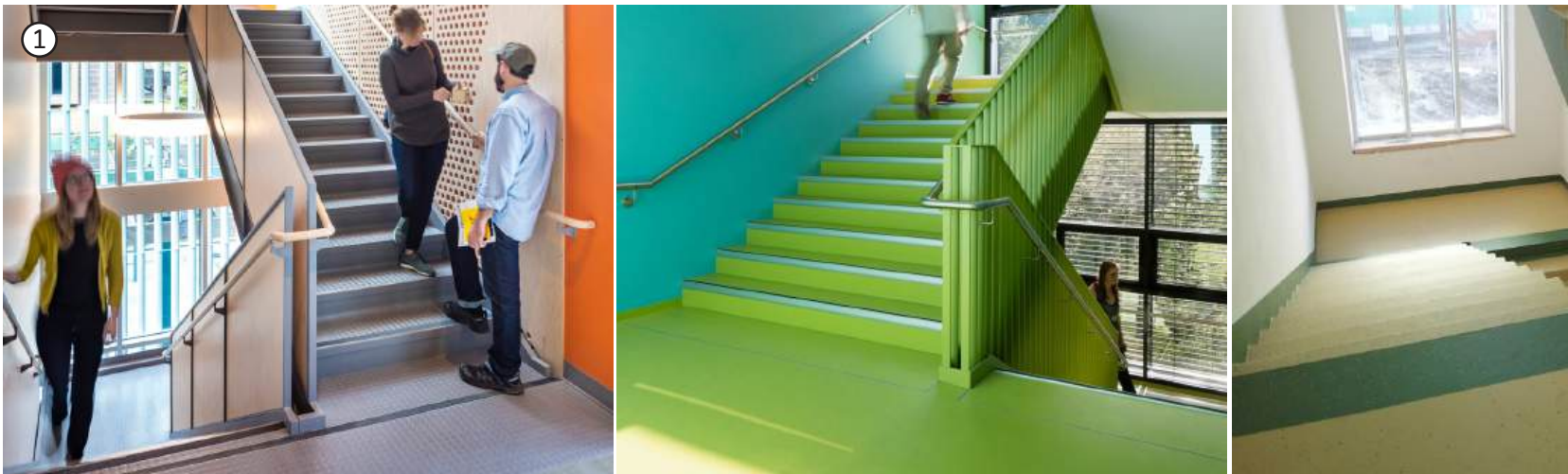
1. Бесшовные покрытия ступеней: бетонные, каучуковые, полимерные и пр.
