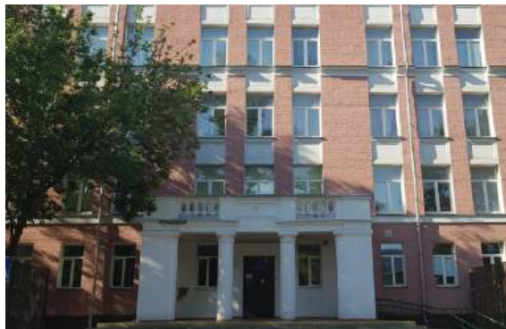
Коррекционная школа № 79, г. Москва
