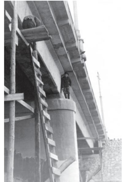
расставленными на определённых, наиболее напряженных сечениях конструктивных элементов: балок, раскосов, верхних и нижних поясах ферм. По этапам загрузки инженеры снимали и записывали показания приборов (10–15 на каждого).
