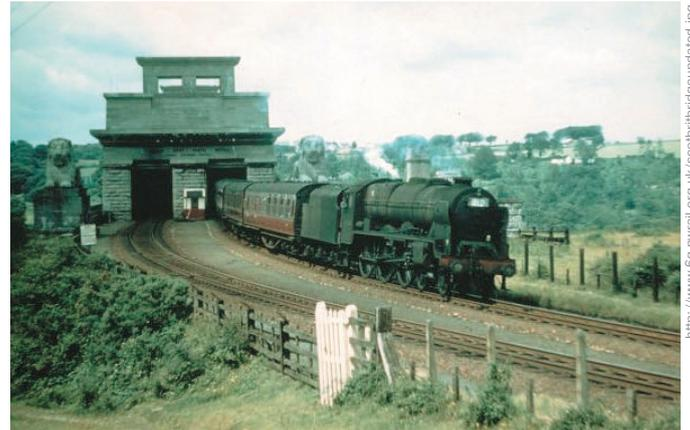
Мост «Британия», способный выдерживать большие динамические нагрузки, вызываемые движением поездов, и не мешающий судоходству в проливе. Сооружён в виде двух основных пролётов длиной около  $140$  м каждый и двух дополнительных пролётов примерно по  $70$  м. Общая длина моста в виде единой трубы составила около  $1511$  футов ( $\approx 461$  м). В 1970 г. перестроен в связи с пожаром
